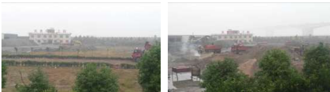
图 6.2-2 杭州天恩环境工程有限公司场地现状
