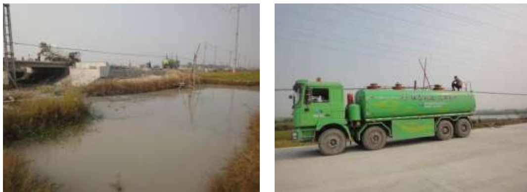
图 6.2-3 绍兴同类工程桥梁钻渣泥浆外运处置
